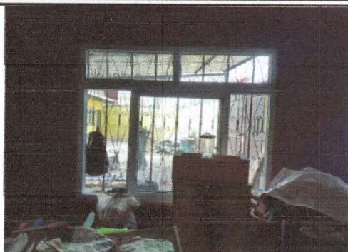
Foto 1: Reparación de ventanas
