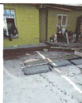
Foto 4: Reparacion de piso de patios
