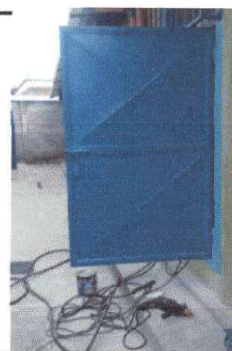
Foto 6: Reparación de puertas de servicios sanitarios
