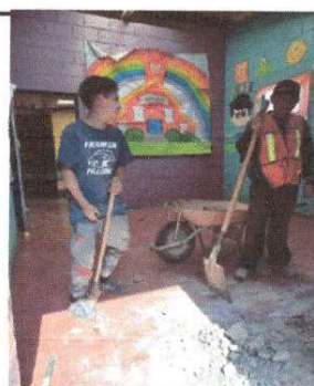
Foto 6: Reparacion de Piso de aulas
