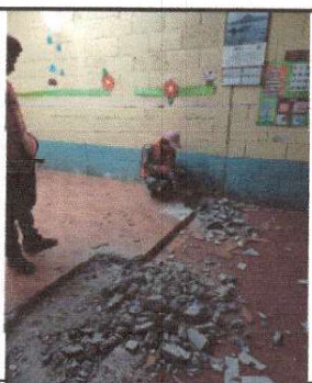
Foto 5: Reparación de piso de aulas
