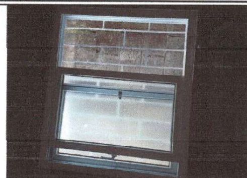
Foto 2: Reparacion de Ventanas
