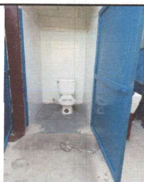
Foto 3: Reparación de taza de servicio sanitario
